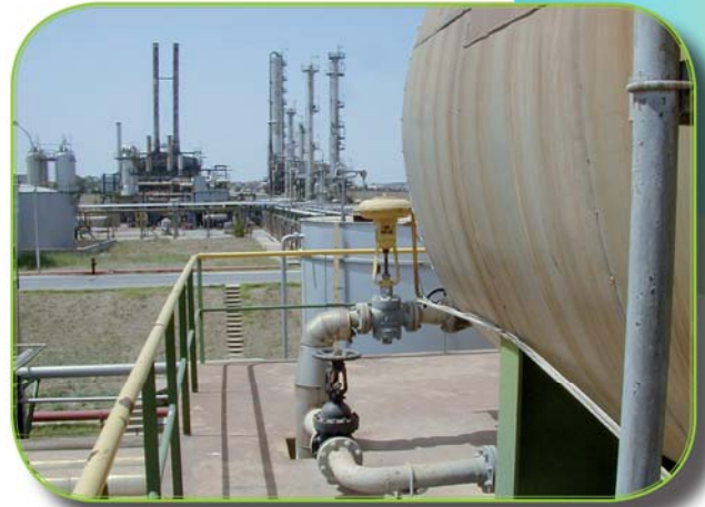
Dégazage Thermique Industrie Pétrolière
